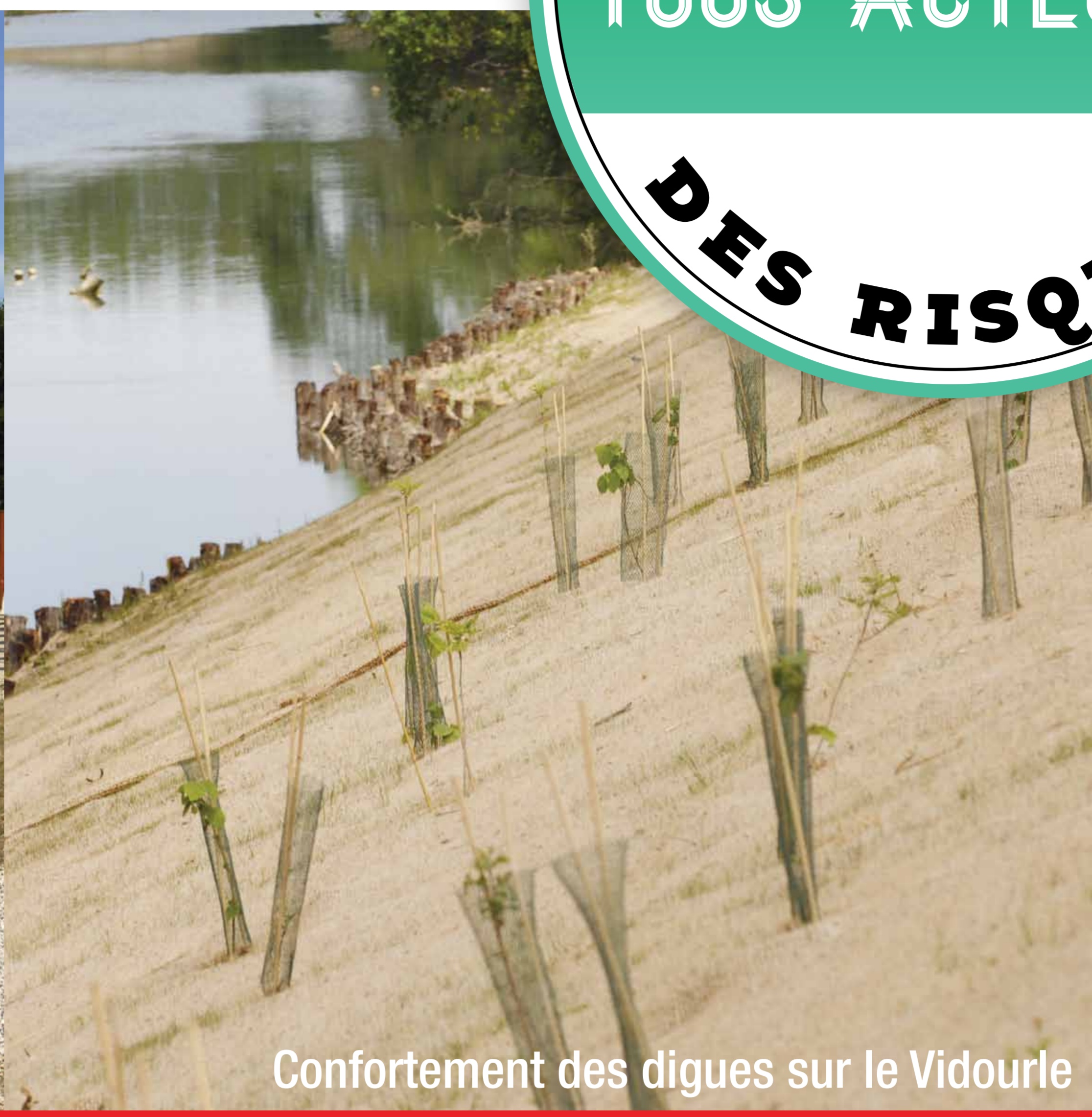
Peignes à embâcles sur la commune de Sommières
