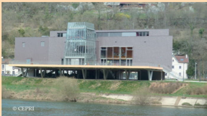
Dans le secteur des Prés-de-Vaux, la salle de spectacles "La Rodia" a été construite sur pilotis. © CEPRI.
