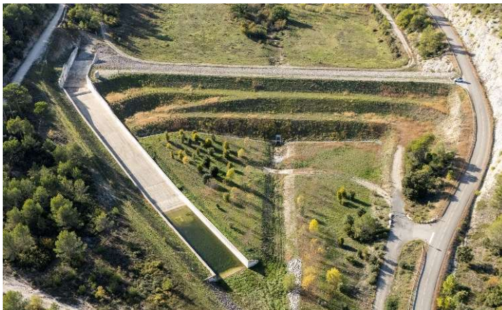
Barrage de Saint Geniès de Malgoirès
