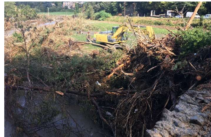
Intervention post crue 2020 – Gardon de Saint Jean
