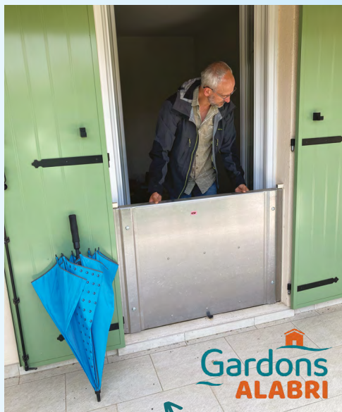
Pose d'un batardeau
