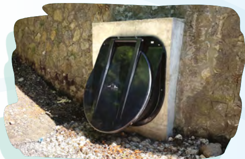
Clapet anti-retour de la digue de La Grand Combe et entretien de la station de pompage de la digue de Comps
